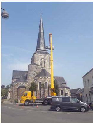
► L'entourage de l'horloge en zinc de l'église a été détérioré par les choucas (aussi appelés corneilles des clochers). Le site a été sécurisé et une intervention a été programmée pour réaliser la réparation et aussi le remplacement d'ardoises sur le clocher. L'entreprise RS démoussage de Bazougers a été mandatée pour effectuer les réparations.
